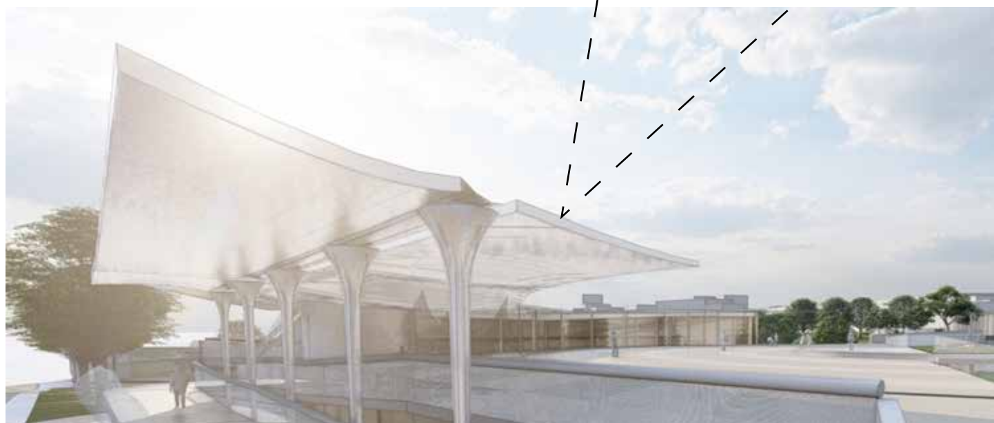
Moduli fotovoltaici con funzione di frangisole
